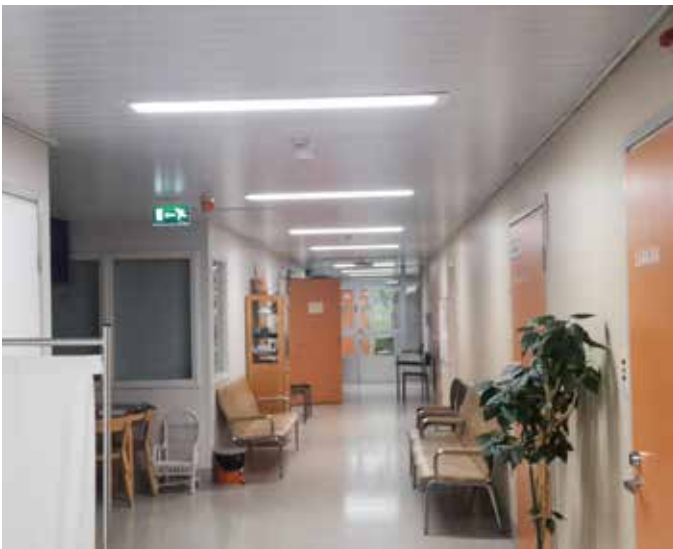
Pornaisten terveyskeskuksen sisävalaistus uusittiin koko rakennuksen osalta energiatehokkailla LED-valaisimilla
