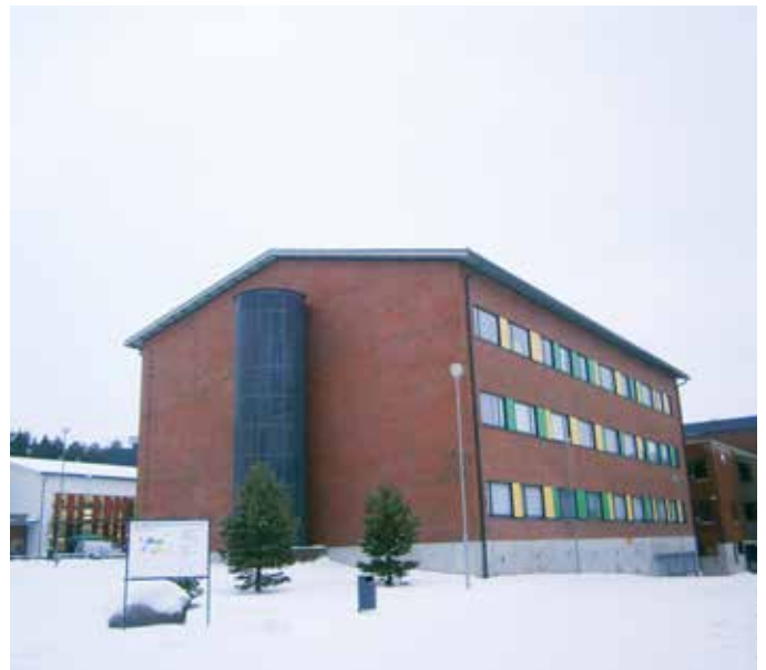
Nummelanharjun koulukeskus Vihdin Nummelassa sekä sen vieressä oleva uimahalli siirrettiin öljylämmityksestä hakelämpöön. Jatkossa uusiutuvan energian osuutta rakennusten lämmityksessä on tavoitteena Vihdissä lisätä edelleen.
